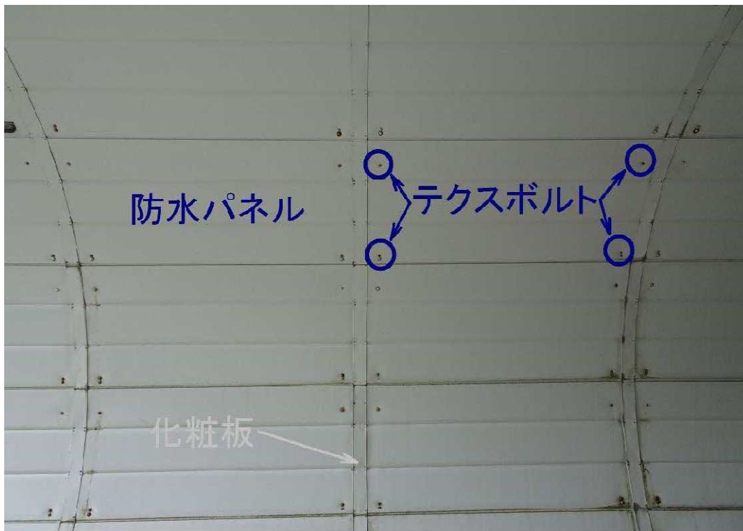
図 1.6 テクスボルトと防水パネル
